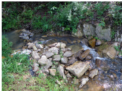
石組みによる落差緩衝
