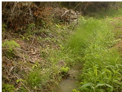
素掘りの土水路
