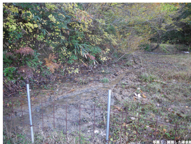
写真①: 開削した導水路
